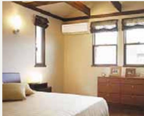
Splitunit: De binneneunit is in de hoek van de kamer zichtbaar
